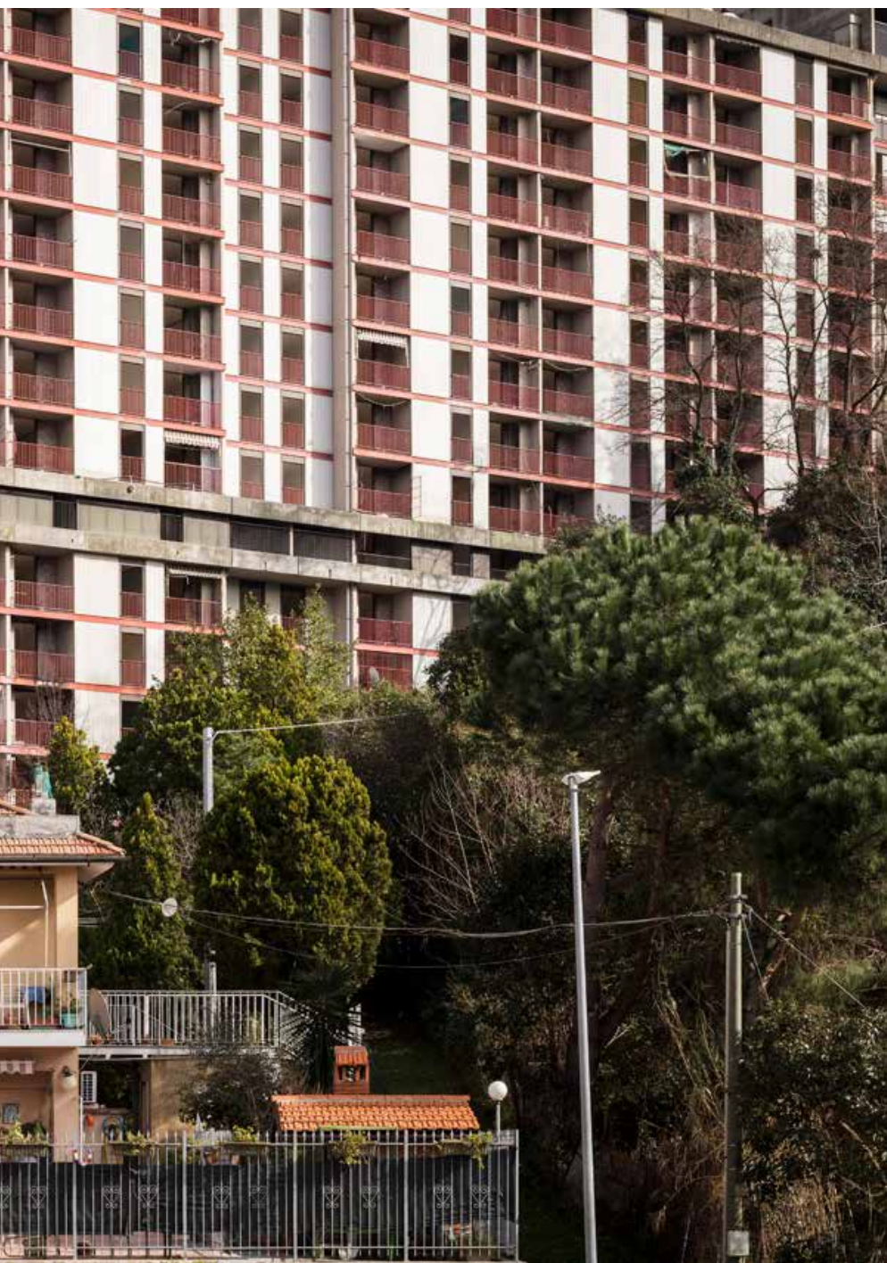
Diga di Begato, Genova, 23 febbraio 2021, ore 14:54
