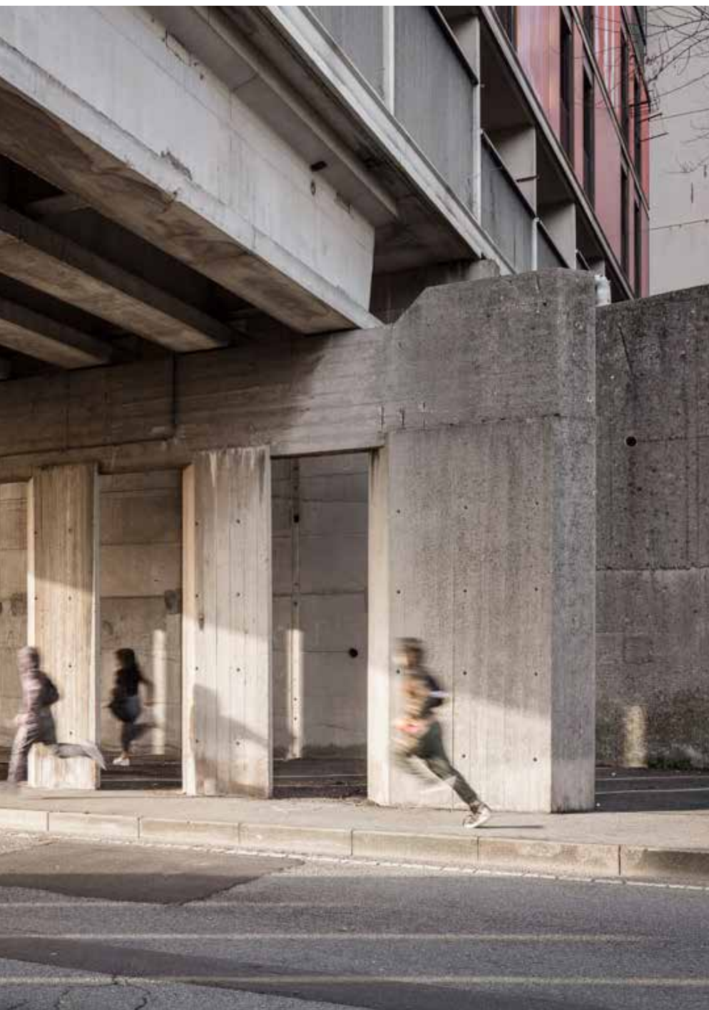
Diga di Begato, Genova, 23 febbraio 2021, ore 17:04
