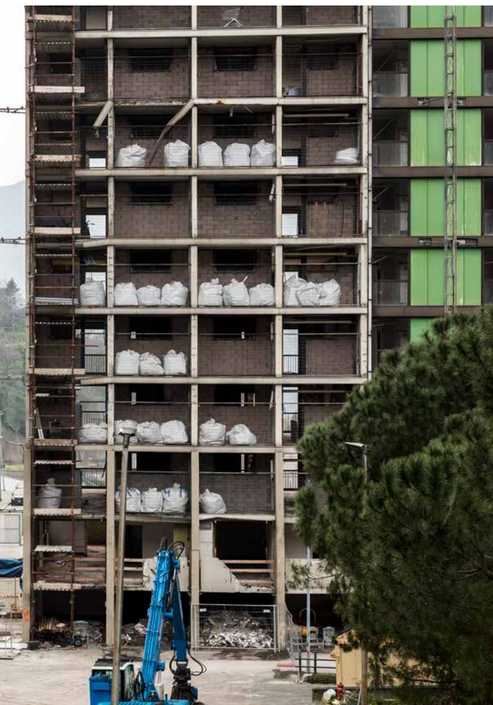
Diga di Begato, Genova, 22 febbraio 2021, ore 16:13
