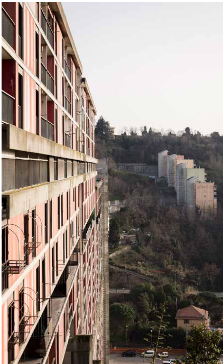
Diga di Begato, Genova, 23 febbraio 2021, ore 16:43
