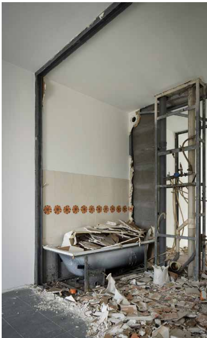
Diga di Begato, Genova, 23 febbraio 2021, ore 11:15
