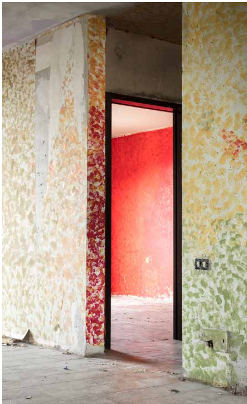
Diga di Begato, Genova, 23 febbraio 2021, ore 12:00
