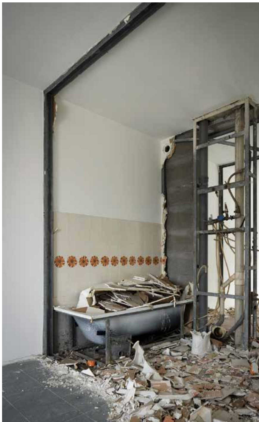
Diga di Begato, Genova, 23 febbraio 2021, ore 11:15
