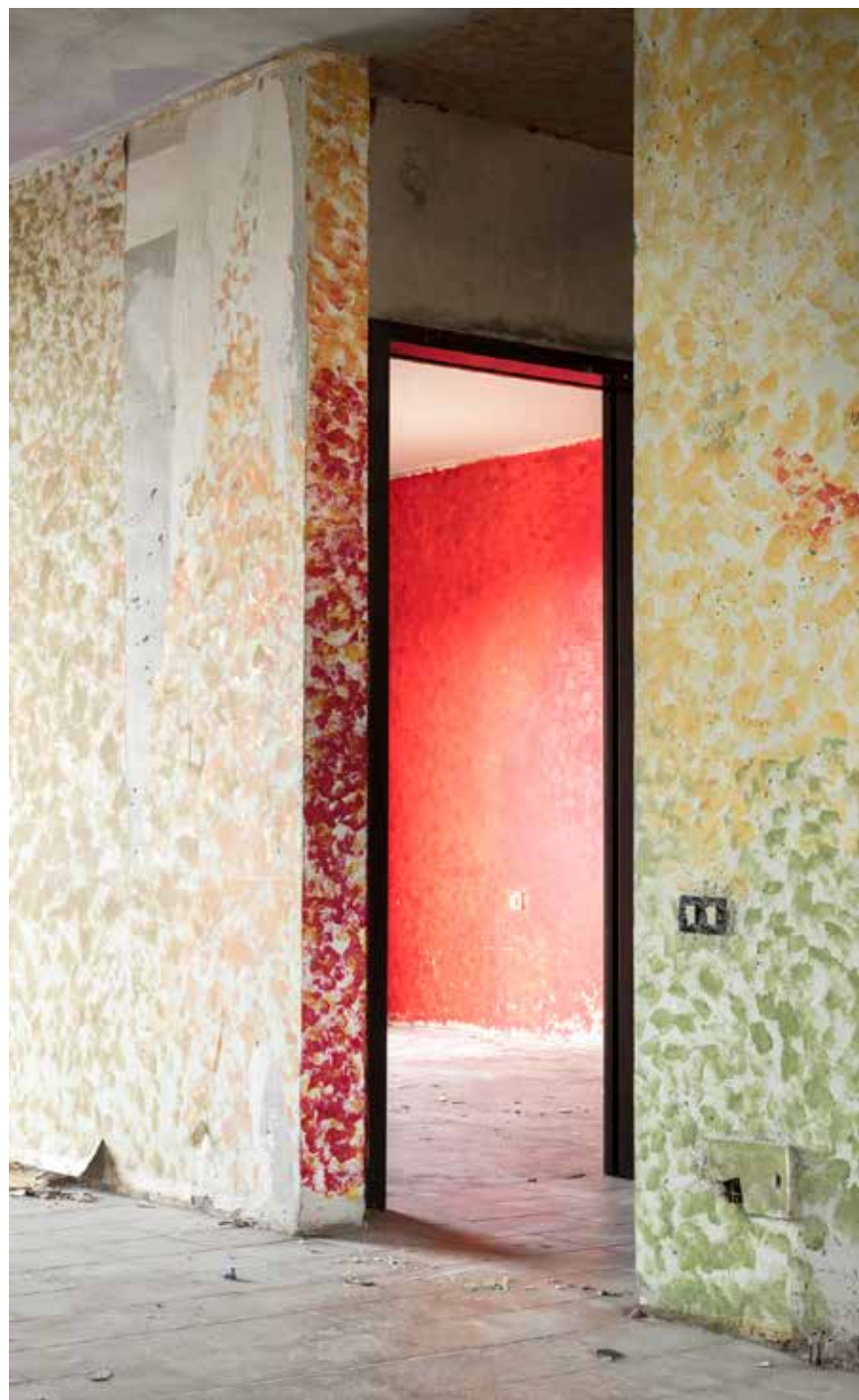
Diga di Begato, Genova, 23 febbraio 2021, ore 12:00
