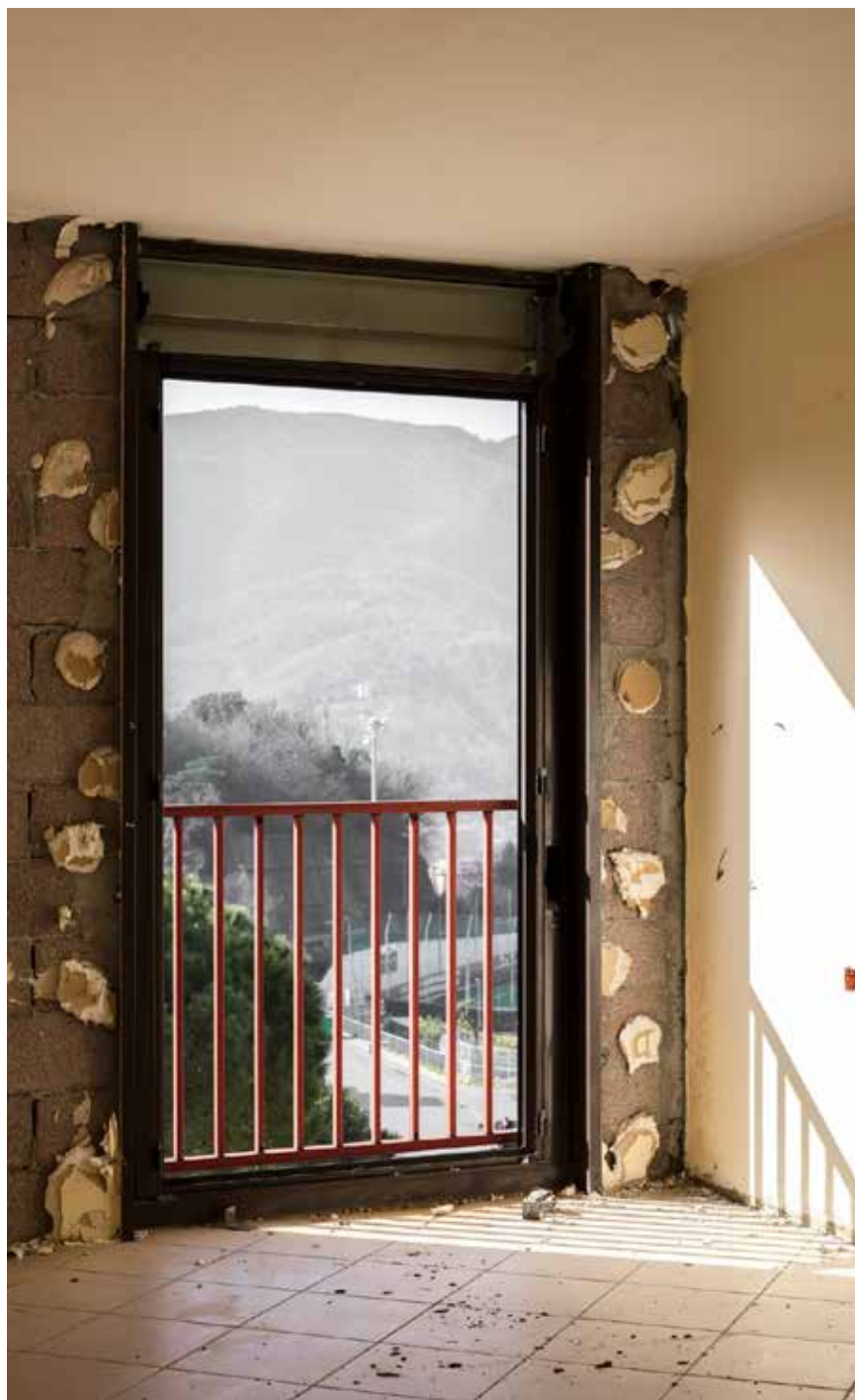
Diga di Begato, Genova, 24 febbraio 2021, ore 14:38
