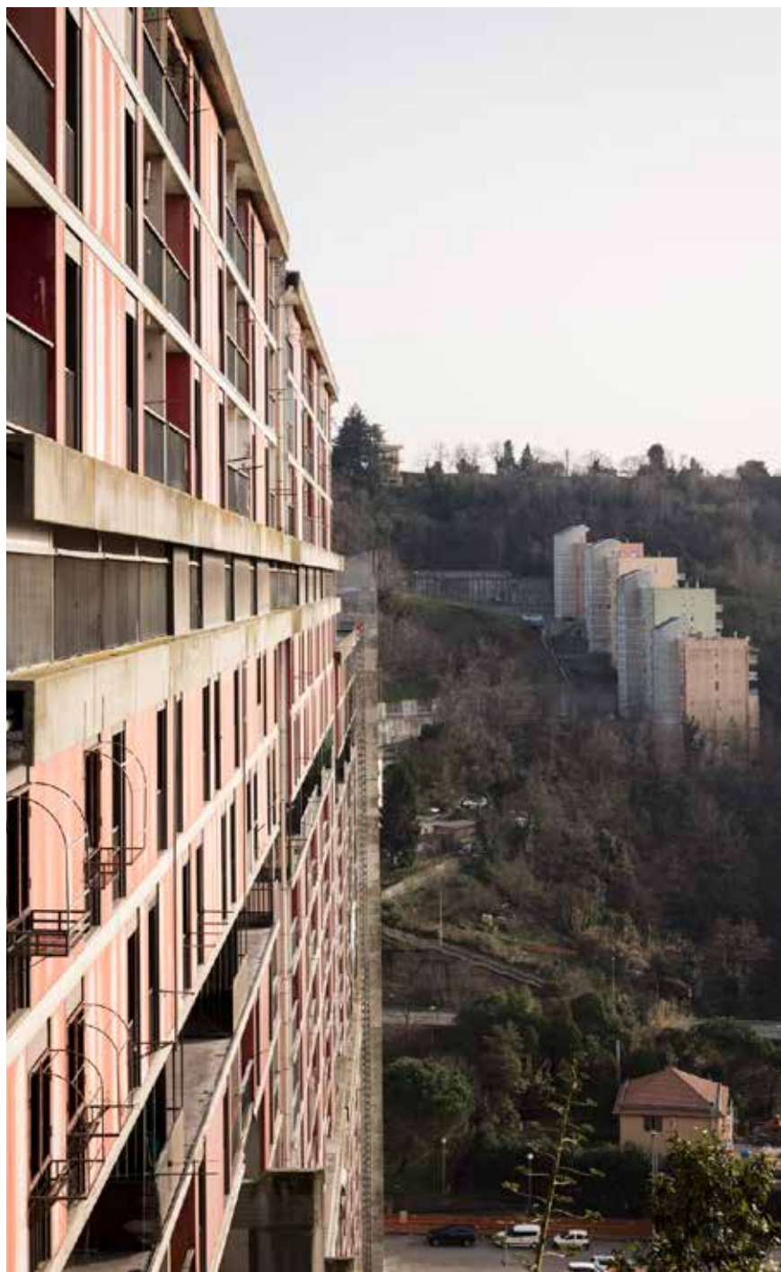
Diga di Begato, Genova, 23 febbraio 2021, ore 16:43
