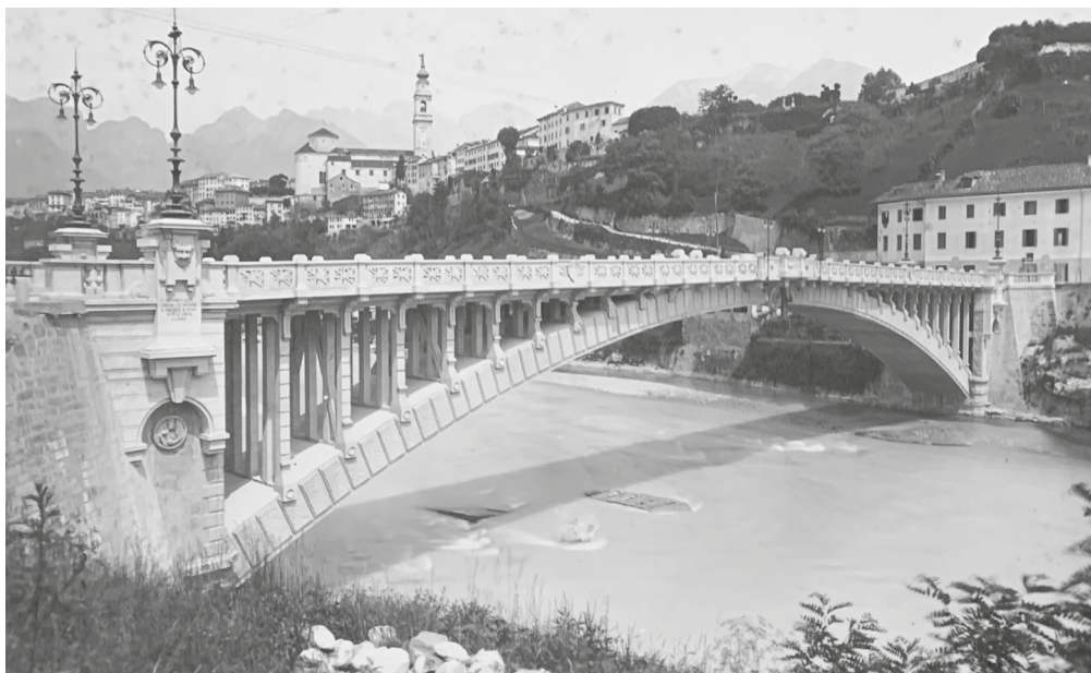
Eugenio Miozzi, ponte sulla strada statale 51, Ponte nelle Alpi (BL), 1921. Il ponte, in calcestruzzo armato, presenta una balaustra brevettata dalla SACC di Attilio Muggia, presentata all'Esposizione di Torino del 1911
