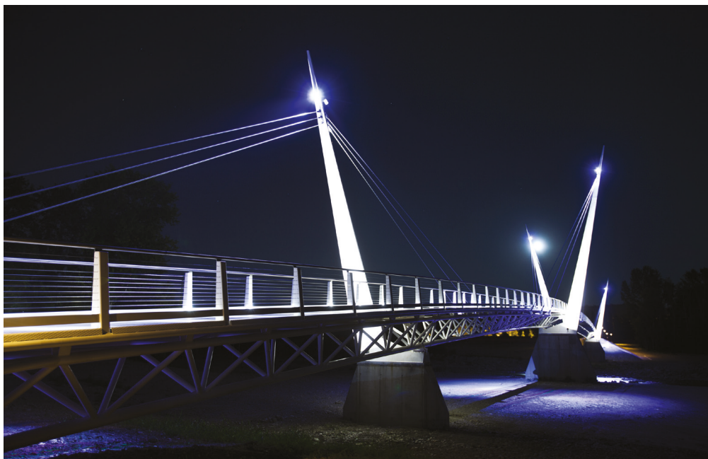
MJW Structures, passerella Cigno sul fiume Reno, Casalecchio di Reno (BO), 2011
